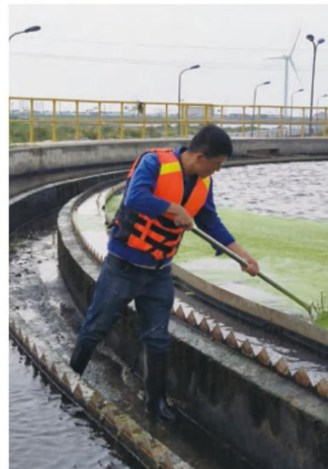
夏季阳光充足，正是各种藻类生长最为活跃的季节。适宜的条件导致水池中藻类和池壁青苔大量繁殖。短期来说，池面上附着着绿藻、青苔，感官效果会变差，不美观，水质看起来浑浊发绿，不清澈。长时间不进行清理，老化的青苔藻类逐渐剥落，有可能会导致的管道堵塞，影响排水等，从而影响到污水处理设施的正常运行生产。所以东营国中环保科技有限公司会定期对二沉池的进行擦洗，同时根据季节变化、天气情况，及时查看藻类生长的情况，调节清洗池壁的频率。
